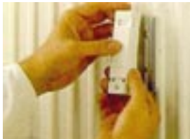
Τοποθέτηση δερμιδομετρητών στο σώμα του καλοριφέρ υπάρχουσας εγκατάστασης.
